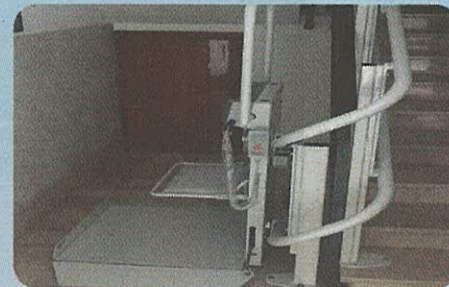
Servoscala a pedana richiudibile
